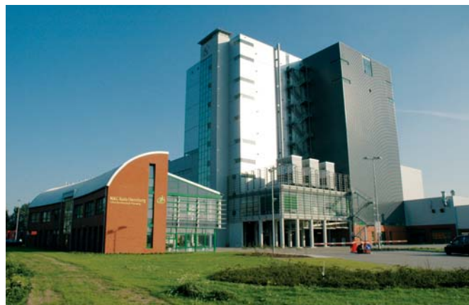
Центр обработки сырого кофе в Гамбурге
