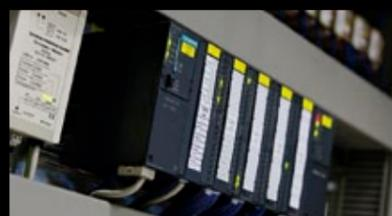
acticool оборудован самой современной системой программного управления, устройствами связи и дистанционного обслуживания, сенсорным цветным дисплеем с визуализацией процесса (трехмерное изображение системы, температурные кривые и т.п.) и возможностью ввода и записи всех параметров продукта и системных данных в рецептурах.
